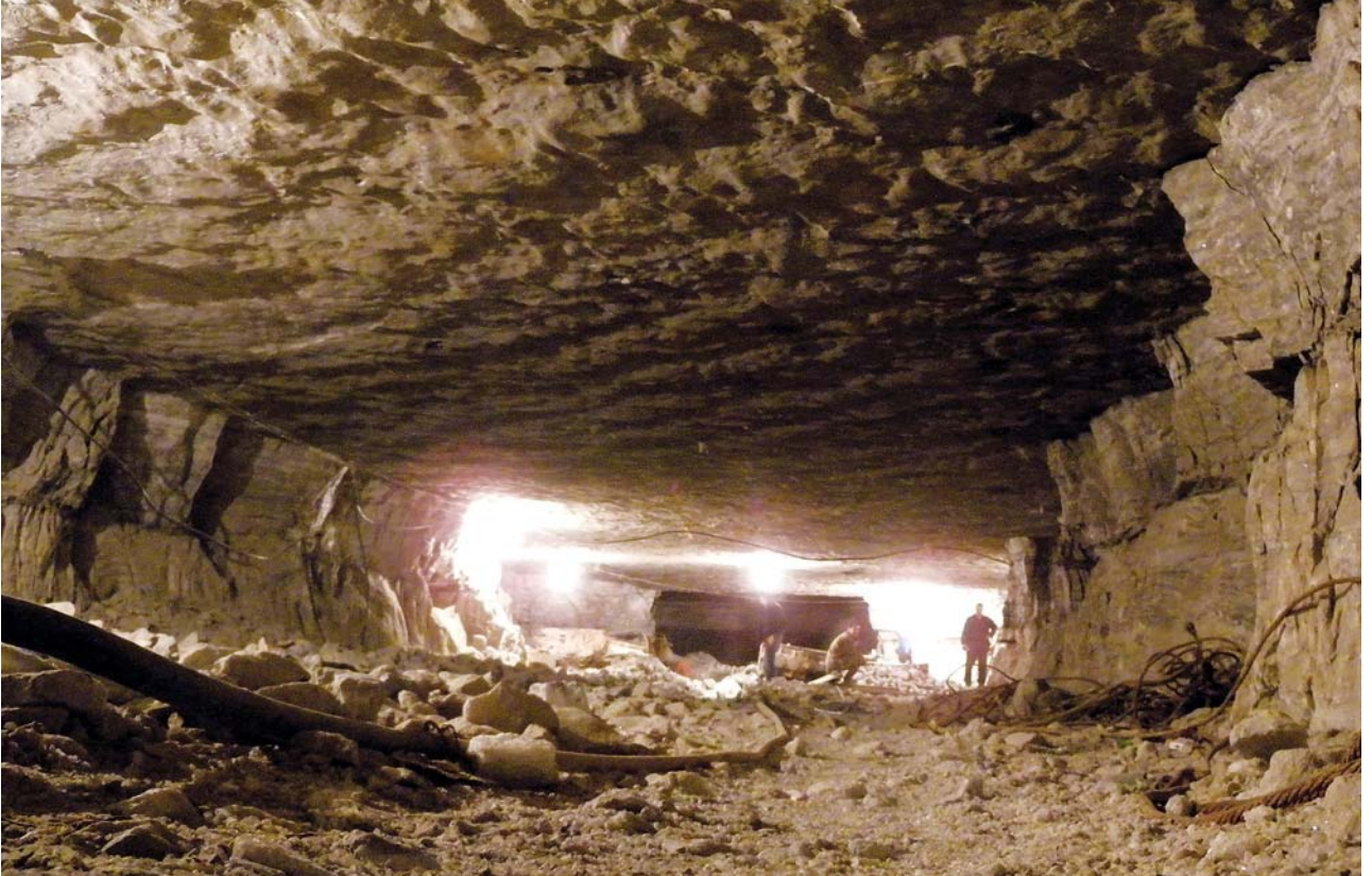
Şəkil 45. Müasir tunel. Figure 45. Modern tunnel.
