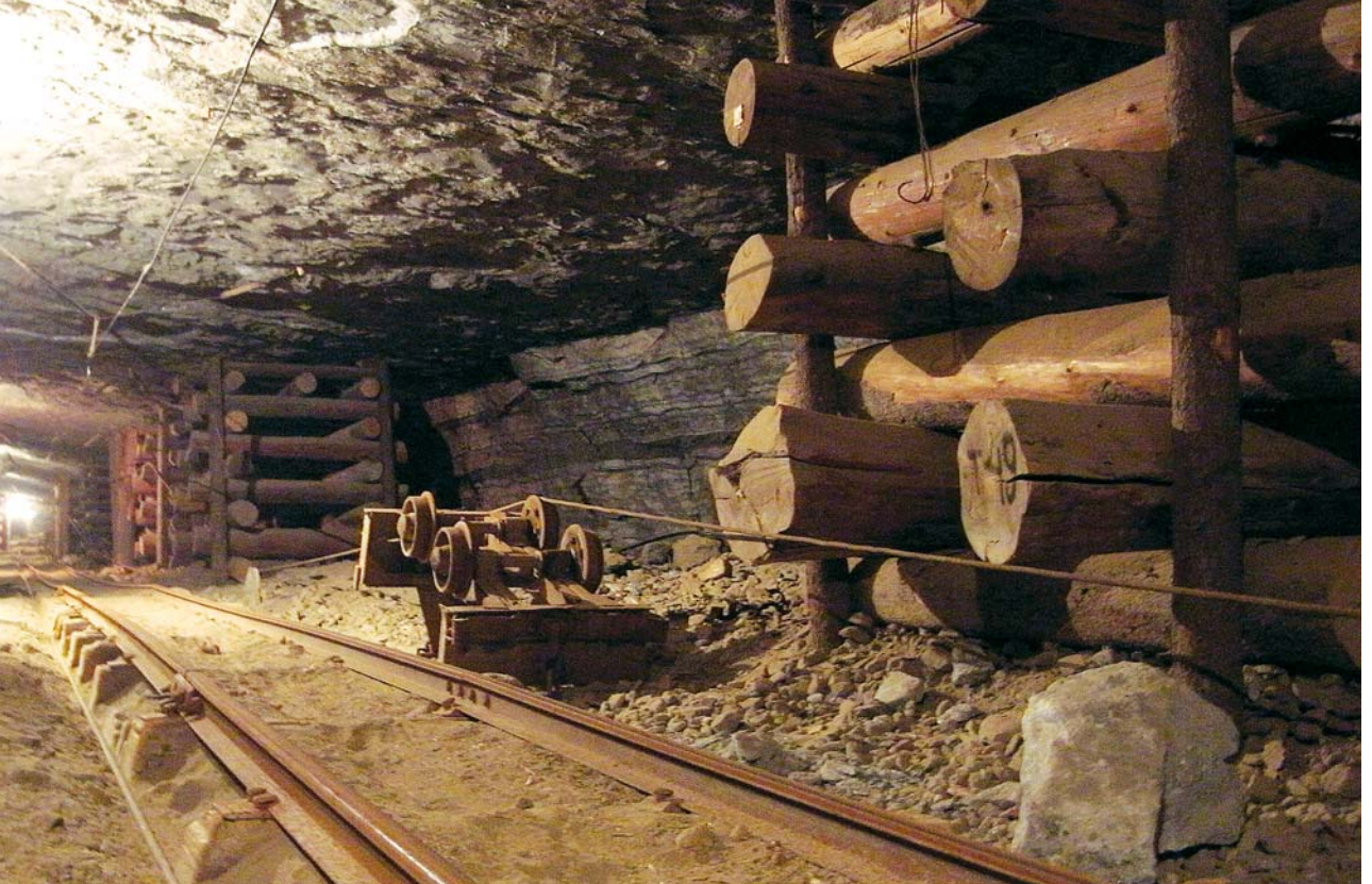
Şəkil 47. Müasir tunel. Figure 47. Modern tunnel.
