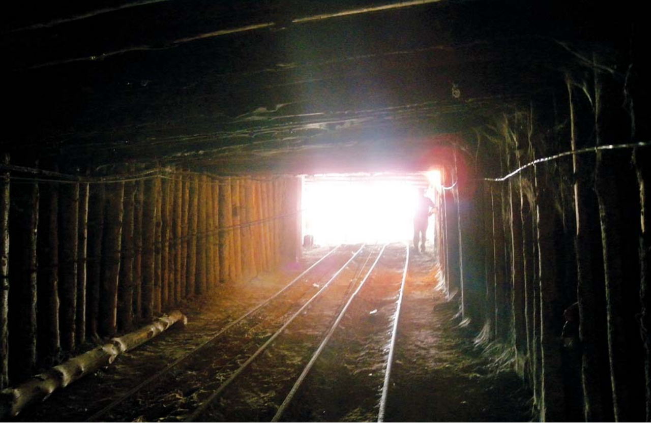
Şəkil 46. Müasir tunel. Figure 46. Modern tunnel.
